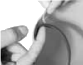
Installation der Dichtung
